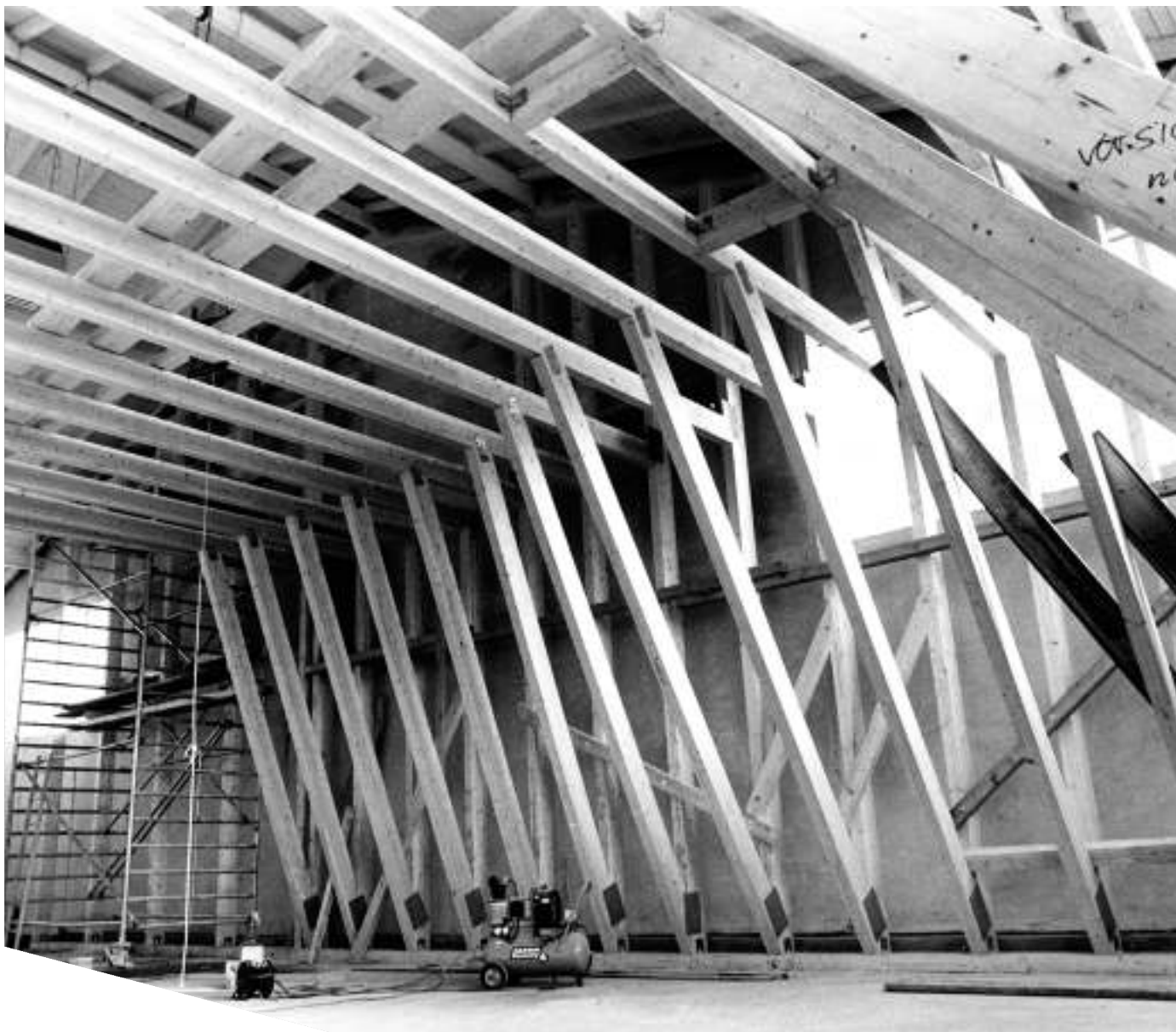
Bau der Kletterhalle für den DAV Sektion Erlangen
